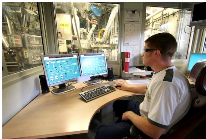
Processövervakning sprängmedelsproduktion Källa: LKAB
